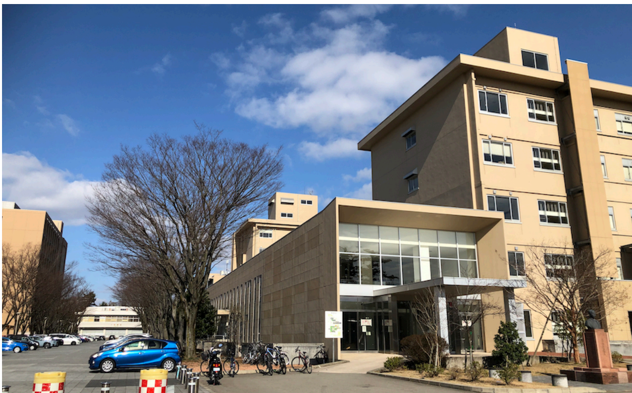
写真3 医学類教育棟・研究棟（左端に見える建物は附属病院）
